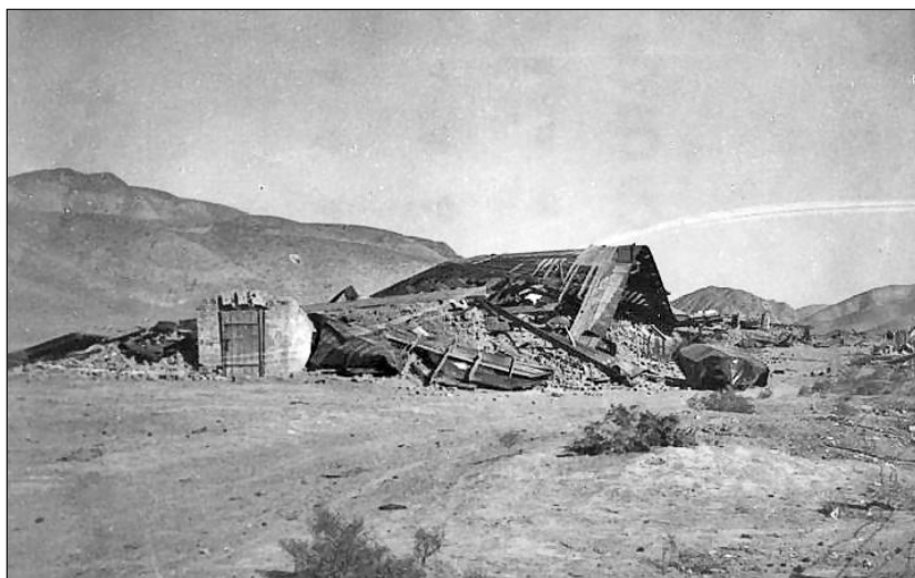
Разрушения в поселке Куру-Гаудан, (к юго-востоку от Ашхабада) соответствуют интенсивности землетрясения X баллов.
