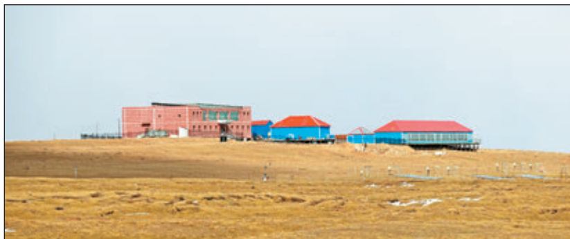
Тибетская высокогорная научно-исследовательская станция СЗИЭПР. Это область сплошного распространения многолетнемерзлых пород. Их мощность здесь варьирует от 70 до 300 м, а льдистость грунтов достигает 50%.
