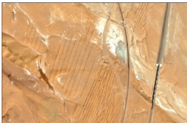
Сетчатые системы защиты от дефляции на высокогорном участке Транстибетской железной дороги.
